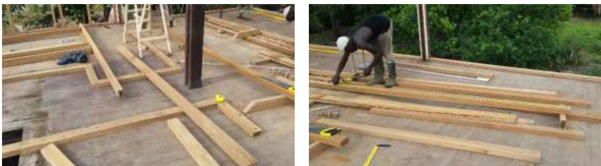
Voorwerk voor de nieuwe muren van termietbestendig cementvezelplaat
